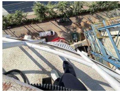
물품 추락 방지 부재 및 측정자의 안전을 고려하지 않은 측정공 위치
